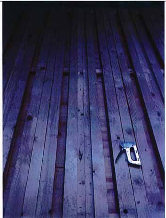
Bild 4: Aufbau. Einsatz von Klammern als Verbindungsmittel der Koppelbretter mit den Wandelementen LIGNO Uni Q3.
