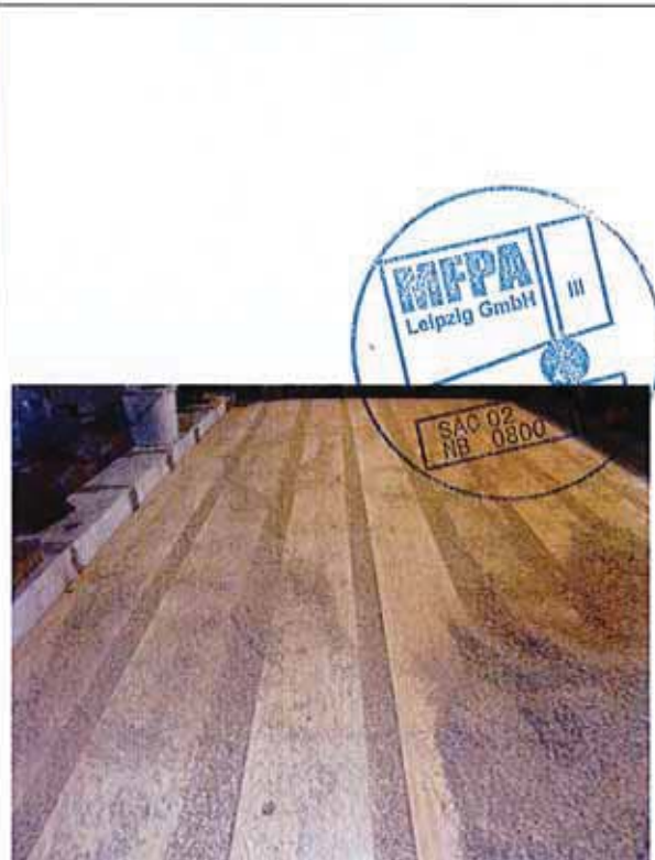
Bild 8: Einbringen der Edelsplitt, Kies, Sand-Füllung.
