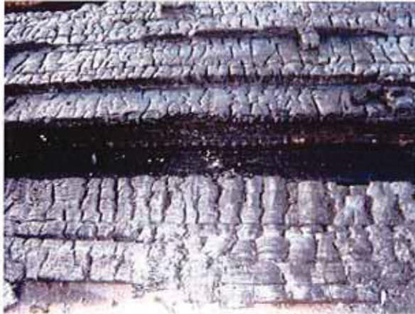
Bild 1: Sichtbarer Einbrand in den Deckenhohlraum.
