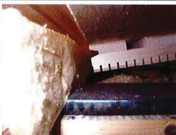
Bild 4: Ausführung der Stoßfuge im unteren Bereich der Akustiklattung sowie der im Wechsel angeordneter Holzlattung und Holzweichfaserplatte.
