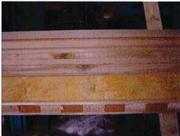
Bild 5: Längsansicht Blick auf die Stoßfuge mit Glaswolle im Bereich des Untergurtes und der unteren Akustiklage.
