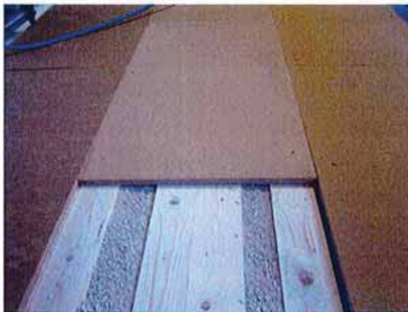
Bild 9: Aufbringen der oberen Holzweichfaserplatte als oberseitiger Deckenabschluss.
