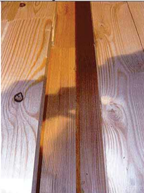
Bild 7: Ansicht der Stoßfuge zweier Deckenelemente. Im Stoßfugenbereich Glaswolle eingelegt.
