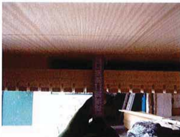
Bild 1: Blick auf die Ebene im Bereich der Akustiklattung bestehend aus einer Ebene mit im Wechsel angeordneter Holzlattung und Holzweichfaserplatte.
