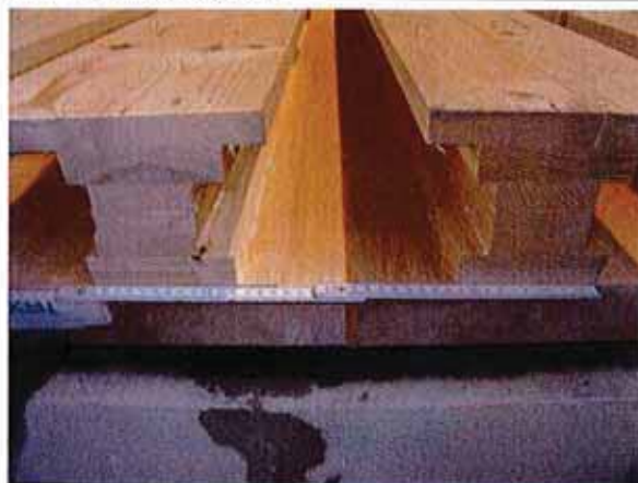
Bild 3: Querschnittsansicht des Deckenelementes LIGNO Rippe Q2 Akustik Z3p im Stoßfugenbereich.
