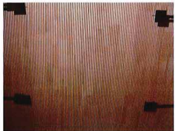
Bild 10: Ansicht der Deckenunterseite eines Deckenelementes LIGNO Rippe Q2 Akustik Z3p mit Blick auf die geritzte Akustiklattung.
