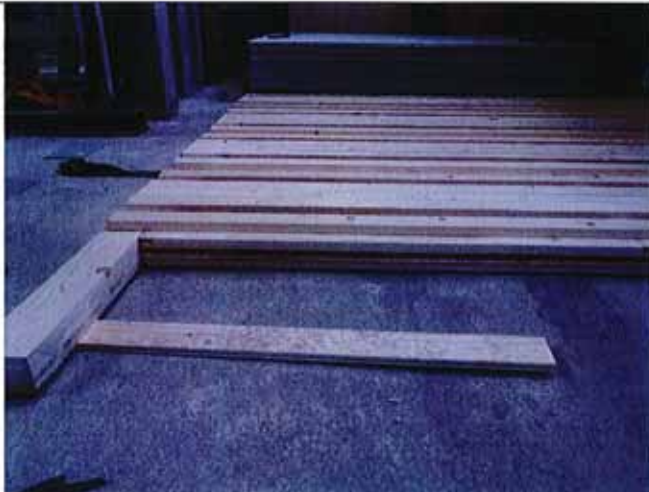
Bild 1: Aufbau der Tragkonstruktion bestehend aus Wandelemente LIGNO Uni Q 3 und einem Stirnholz.
